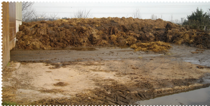
Fumière en Mayenne. L'aire bétonnée permet la récupération des jus et des éléments chargés lessivés par les pluies | Crédit photo : Civam Bio 53
