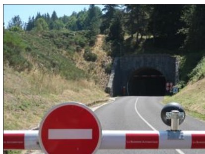
Le Tunnel du Roux, dans la montagne ardéchoise, sera fermé samedi 3 décembre entre 16 et 20 heures. Photo Le DL/Anthony GONZALEZ
